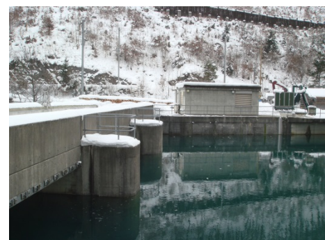
Wehrrücke mit Pfeilern
