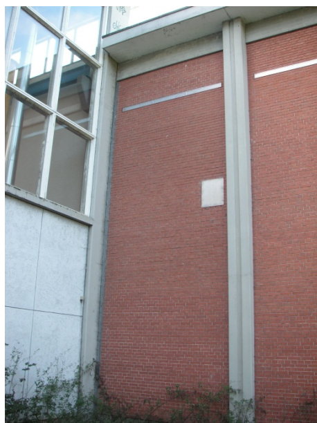
Aussenfassade mit Fugenansicht
