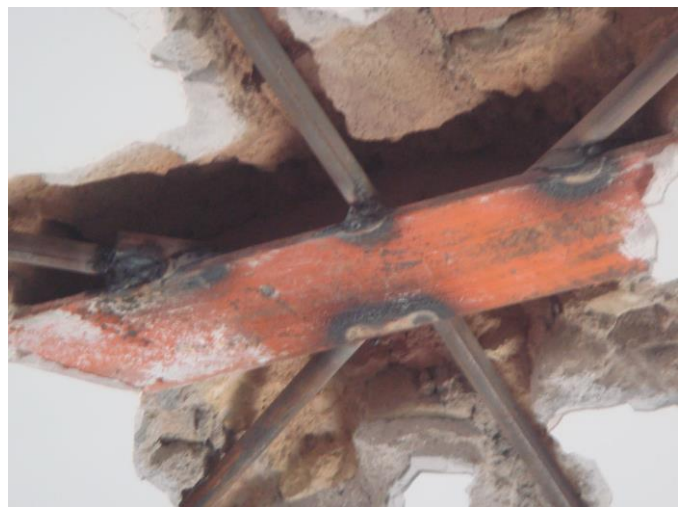
Abb. 11: Verstärkung einer Gewölbedecke durch Einschweissen eines Stahl-Verbandes, Detailansicht der Schweissverbindungen.
