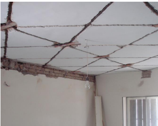
Abb. 10: Verstärkung einer Gewölbedecke durch Einschweissen eines Stahl-Verbandes.
