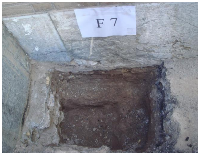
Abb. 6: Orthopädie-Abteilung des Bahonar-Spitals in Kerman: Wandgründung ohne betoniertem Foundation, Gründung besteht aus kalkstabilisiertem Boden und einer Untermauer aus adobem Mauerwerk.
