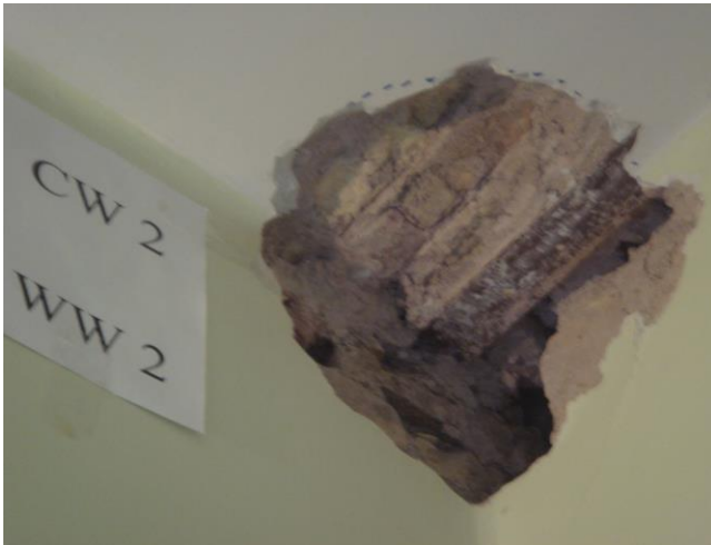
Abb. 5: Orthopädie-Abteilung des Bahonar-Spitals in Kerman: Wand-Deckenanschluss, Gewölbedecke mit nicht verzahnter Trennwand.
